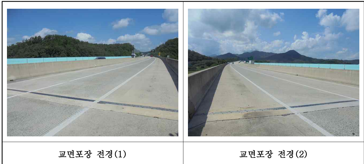
【사진 30.3.19】 교면포장 전경
