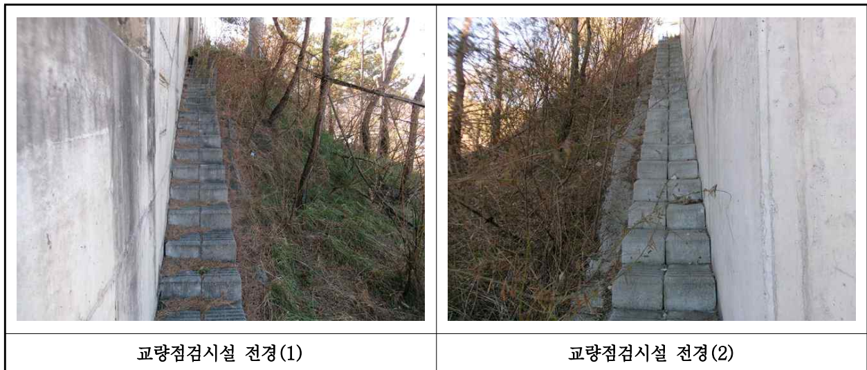
【사진 30.3.25】 교량 점검시설 전경
