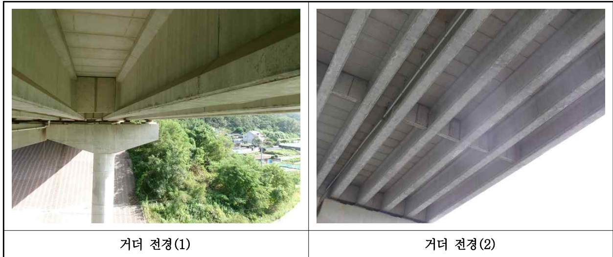
【사진 30.3.4】 거더 전경
