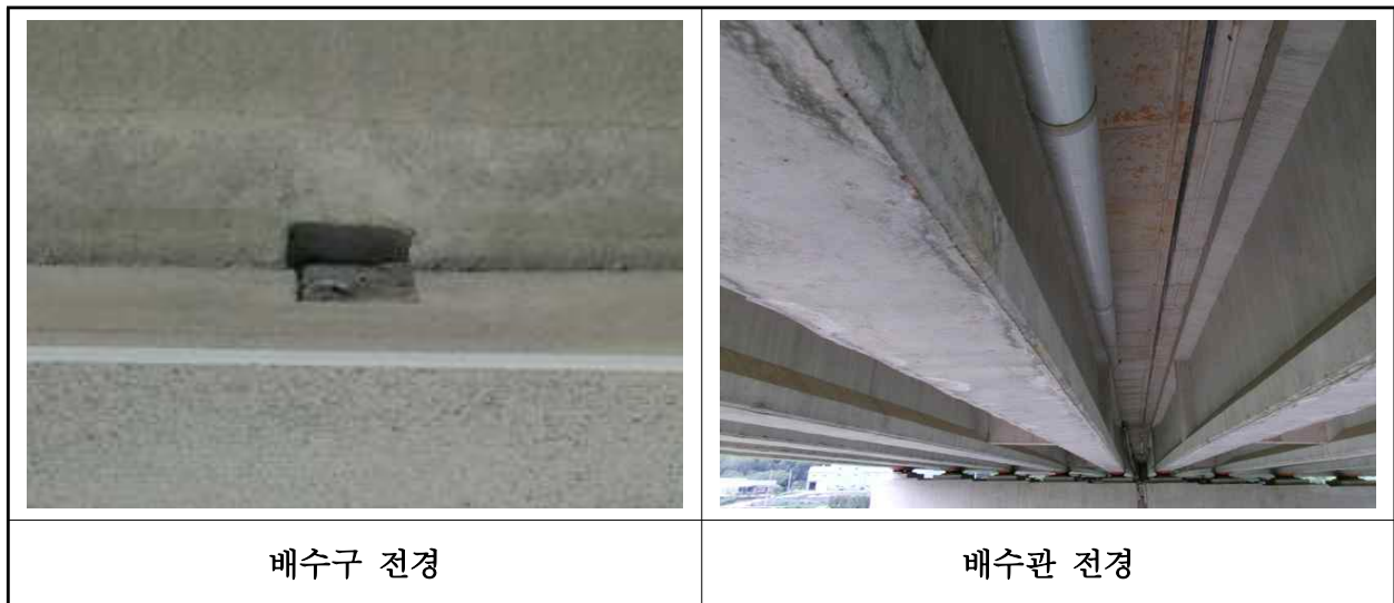
【사진 30.3.21】 배수시설 전경
