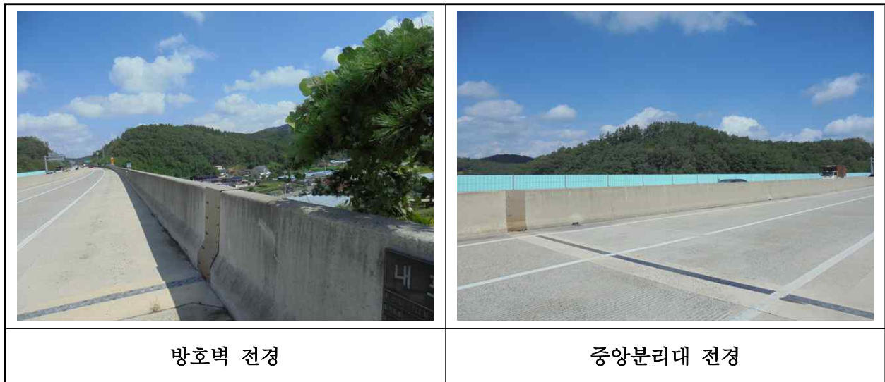
【사진 30.3.23】 방호벽 및 중앙분리대 전경
