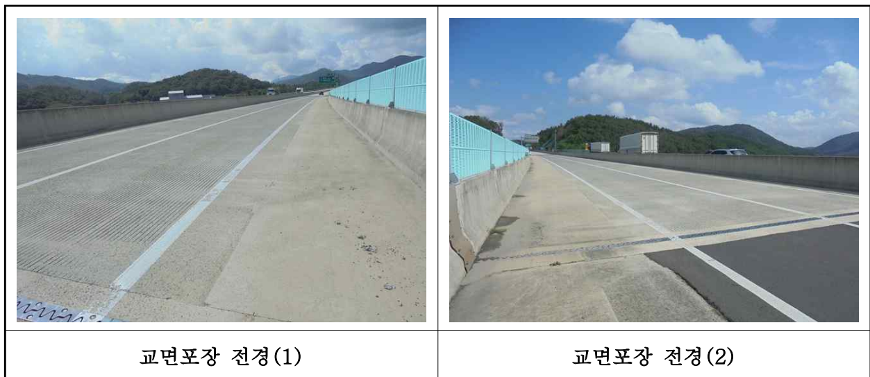
【사진 30.3.44】 교면포장 전경
