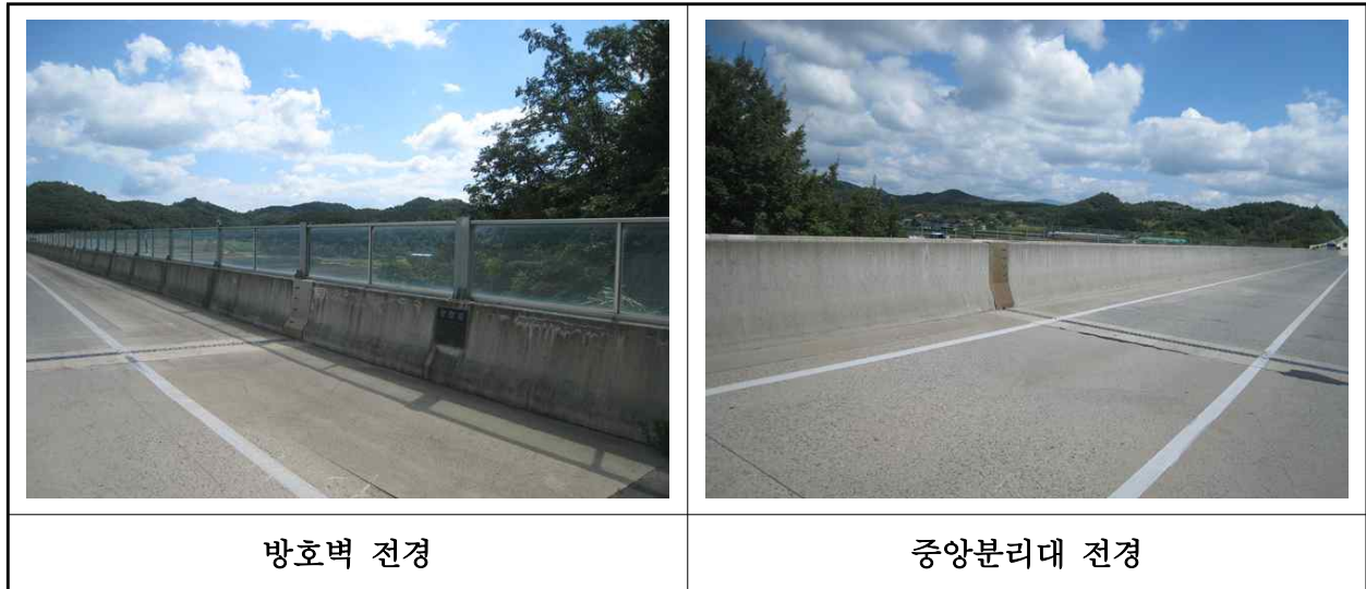
【사진 30.3.48】 방호벽 및 중앙분리대 전경
