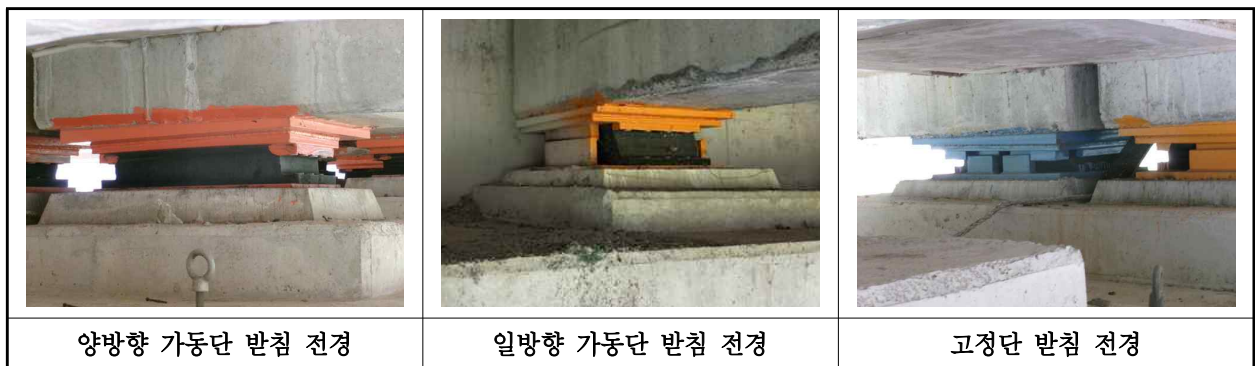
【사진 30.3.37】 교량받침 전경
