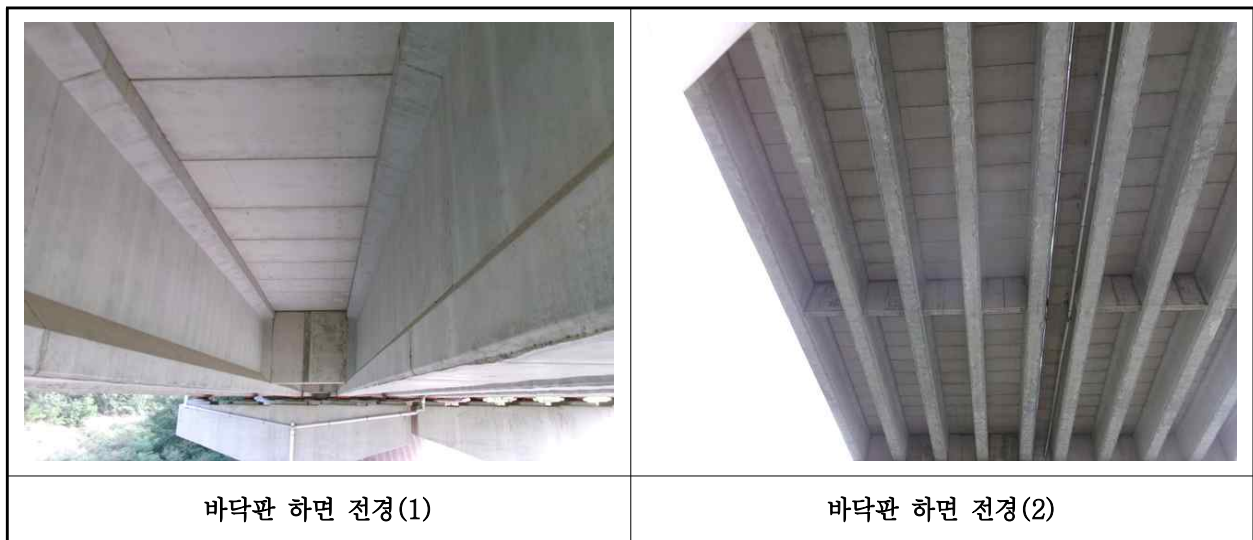
【사진 30.3.27】 바닥판하면 전경
