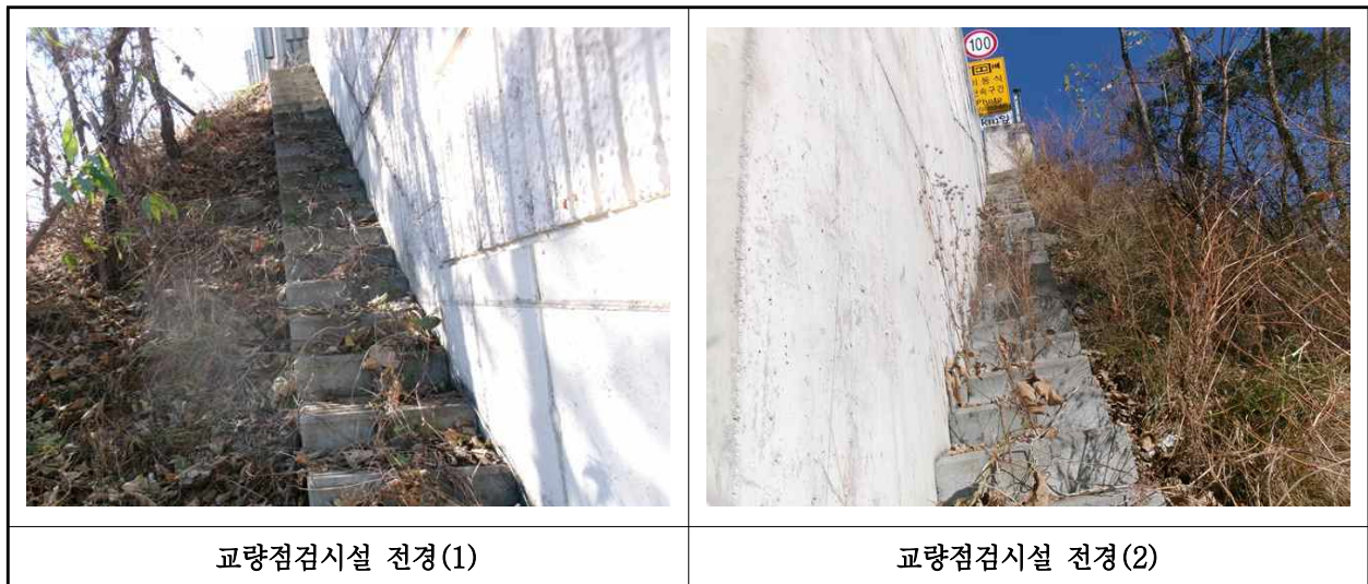
【사진 30.3.50】 교량 점검시설 전경
