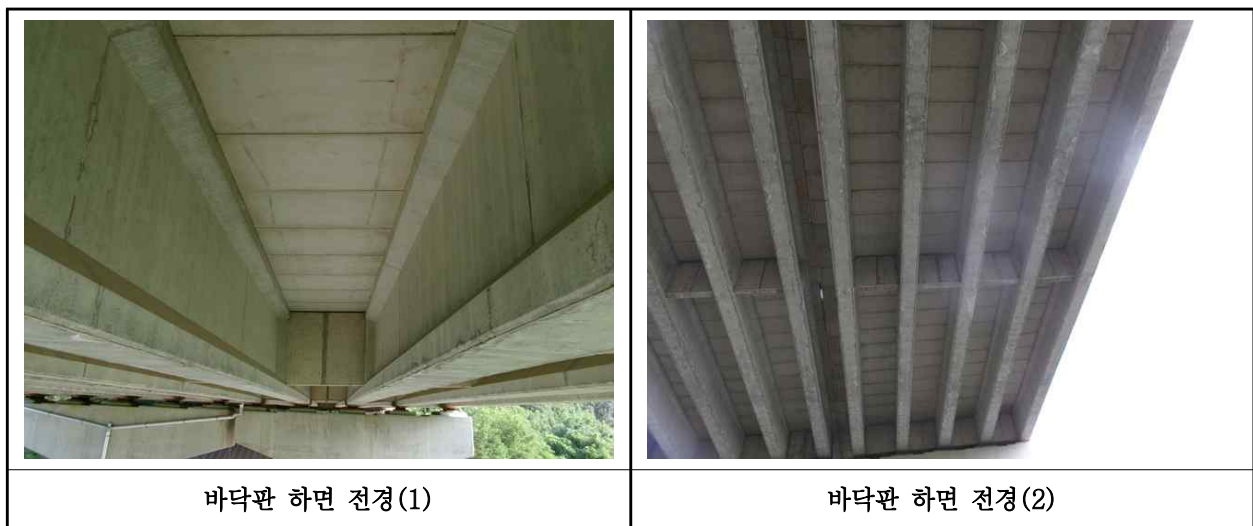
【사진 30.3.2】 바닥판하면 전경
